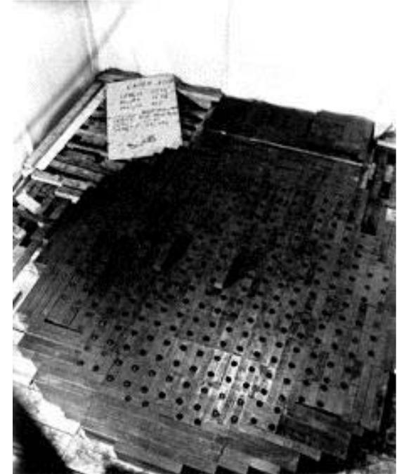
**Empilement de graphite, d'UO<sub>2</sub> et d'uranium naturel à peu près en forme de sphère avec des barres de contrôle en Cadmium**
